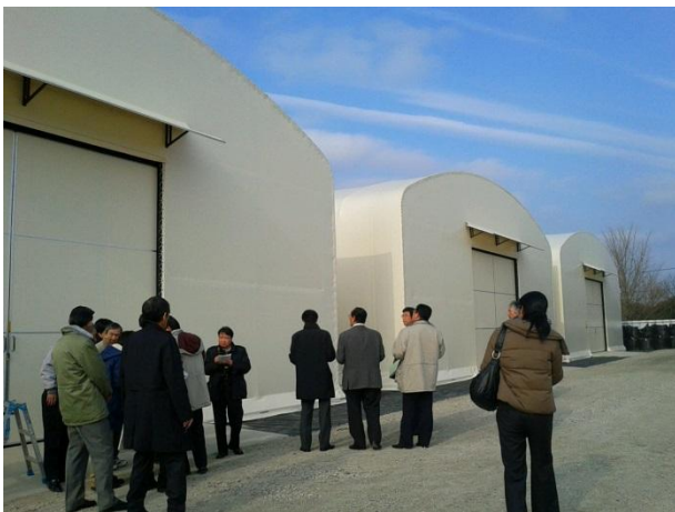
(汚染焼却灰の保管建屋)
